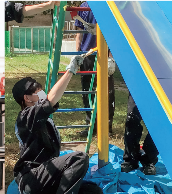
滑り台補修(市内保育所)
